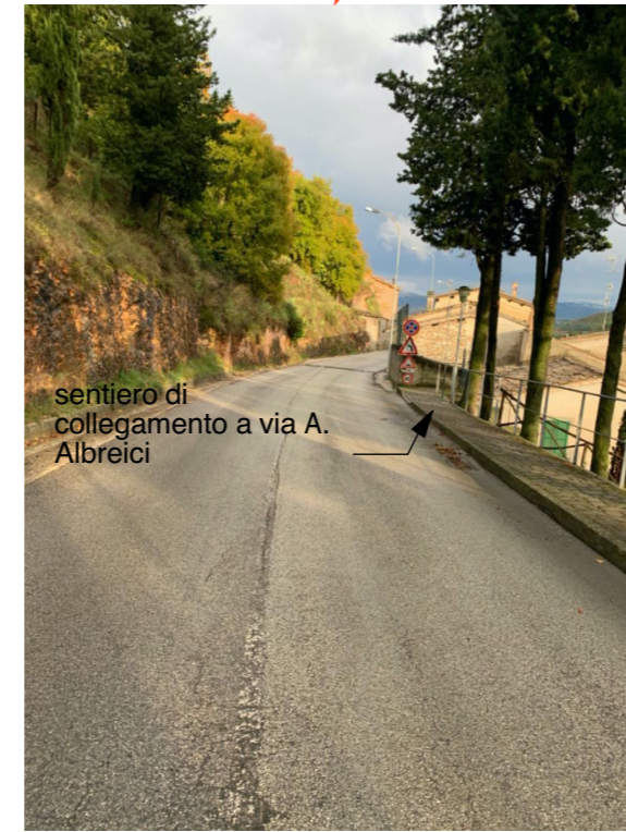
punto particolarmente stretto nel quale la carreggiata comprende le banchine scende a 4,65m.
