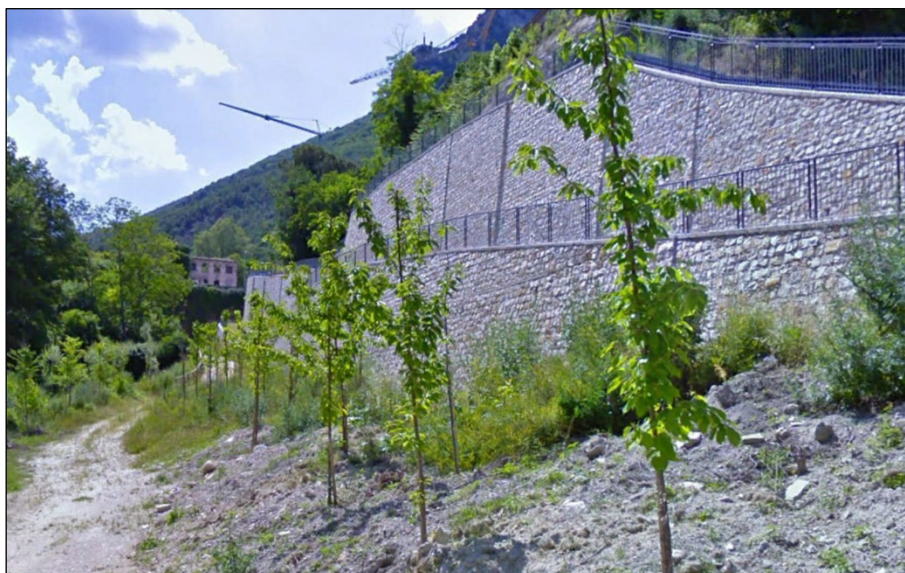
Frana F-12-1580MM_001: doppia fila di muro su pali, tirantati (vista da valle)
