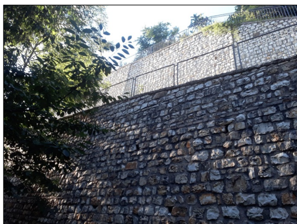
Frana F-12-1580MM_001: doppia fila di muro su pali, tirantati (sponda sx Fiume Esino)
