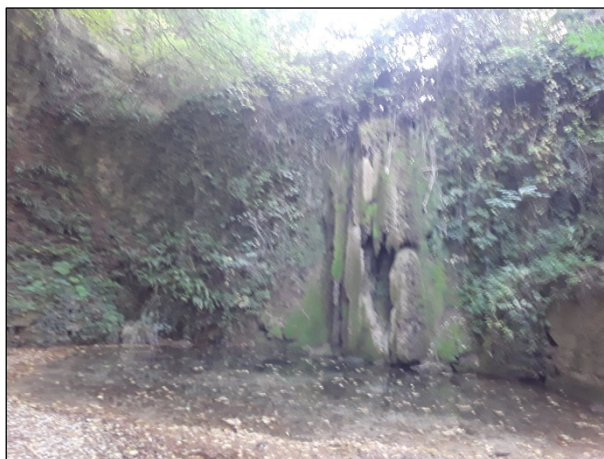
Frane F-12-15780MM_001 e F-12-15780MM_002: depositi di travertino in corrispondenza di una briglia in alveo
