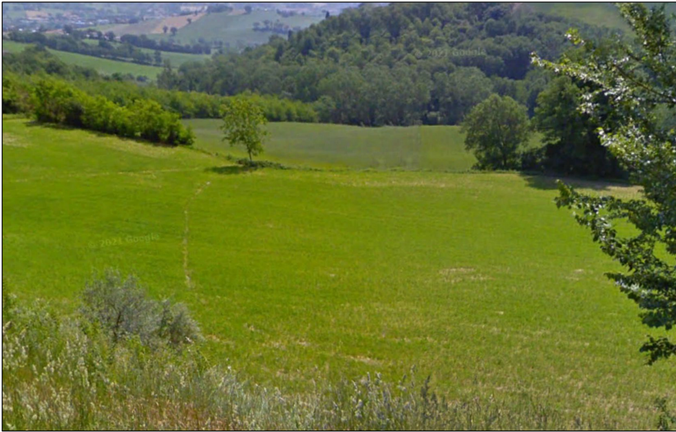
Frana F-12-1497: ripiano nella porzione sommitale del versante, a valle della strada comunale
