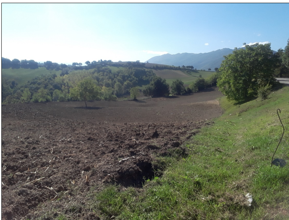
Frana F-12-1497: ripiano nella porzione sommitale del versante, a valle della strada comunale
